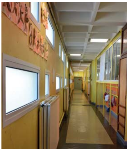
Nouvelles fenêtres pour le couloir de l'école le Ventoulet
