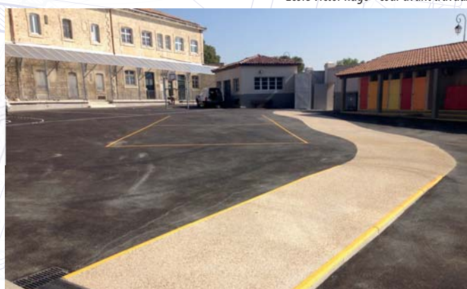
École Victor hugo - cour après travaux
