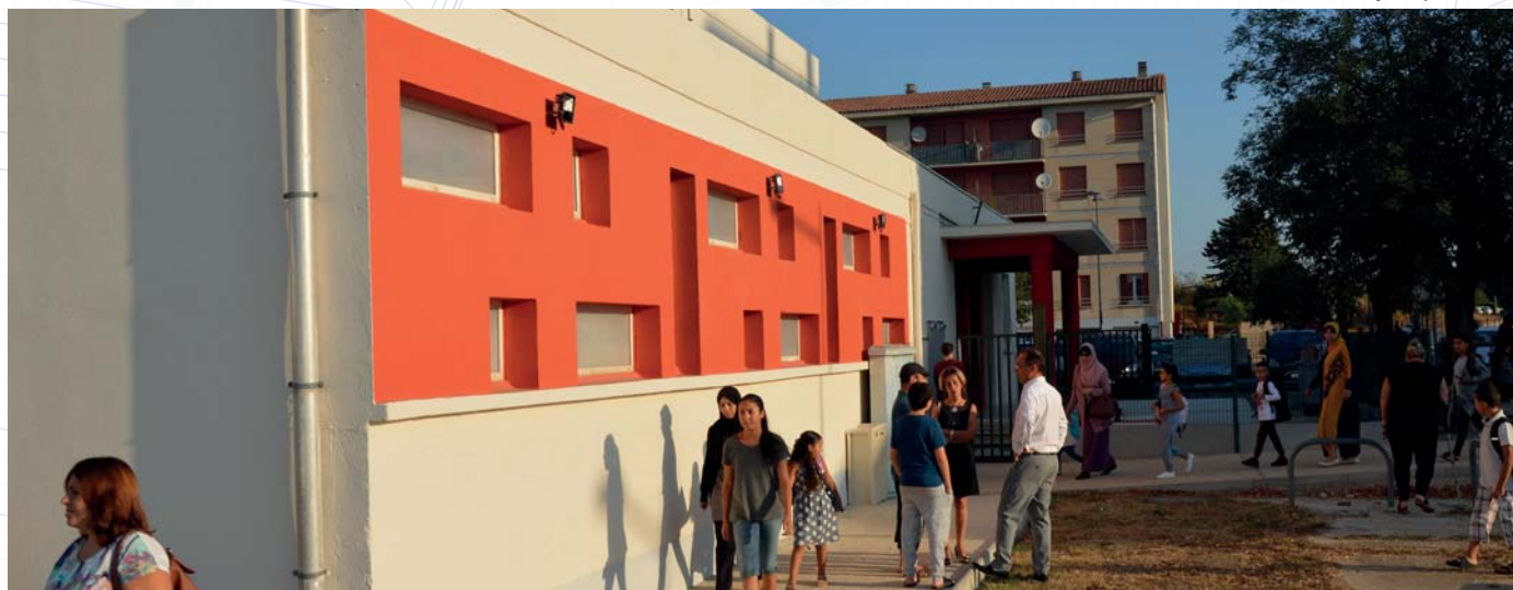
École Laforêt - façade après travaux
