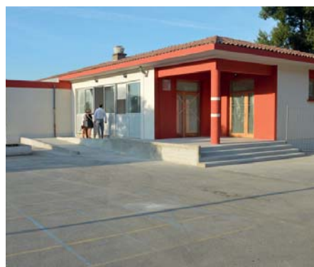
La façade de la future cantine de l'école Laforêt.
