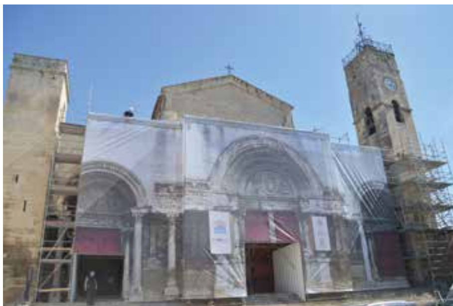
Façade de l'abbatiale en cours de rénovation.
