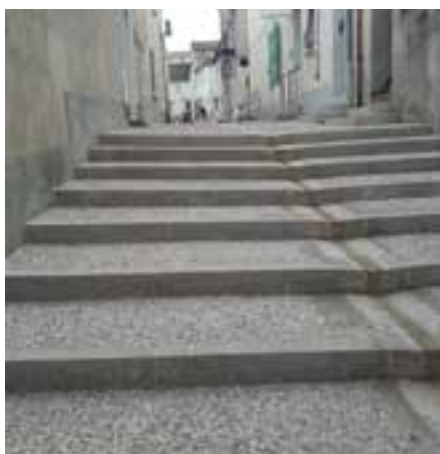
La rue Ernest Renan, en cours de travaux
