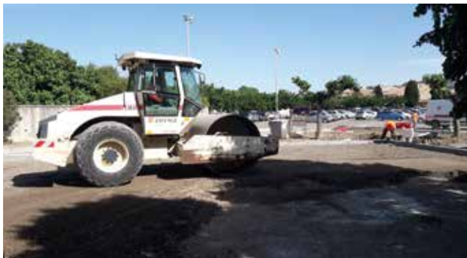
Chantier du parking Charles de Gaulle.
