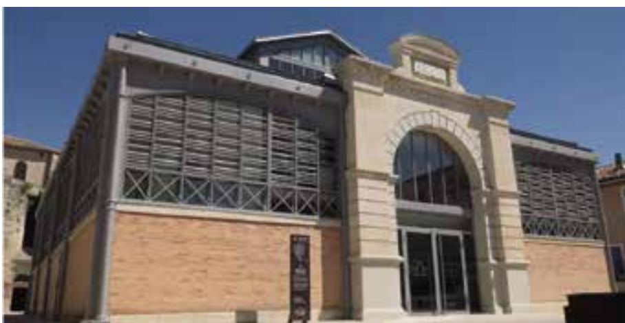
Façade du nouveau Pavillon de la Culture et du Patrimoine.
