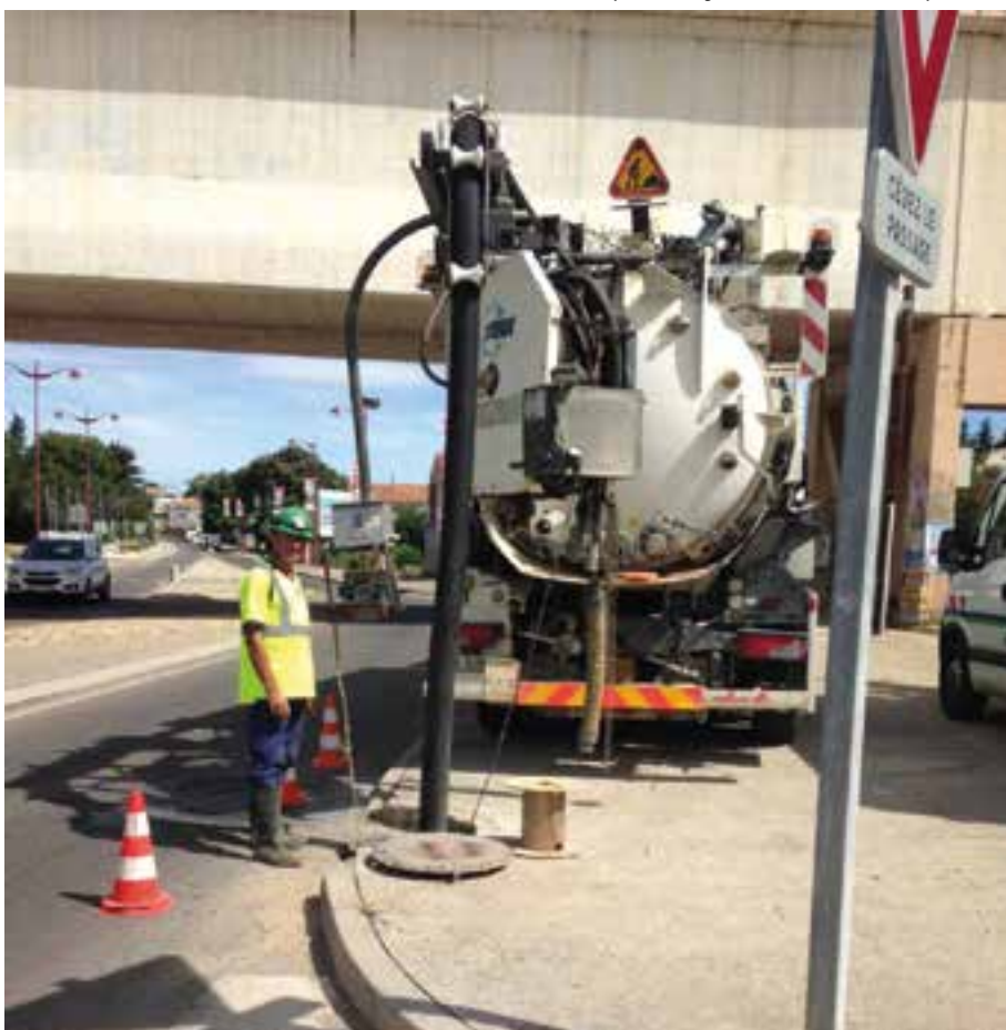
Aspiration des graviers obstruant les réseaux par la SAUR
